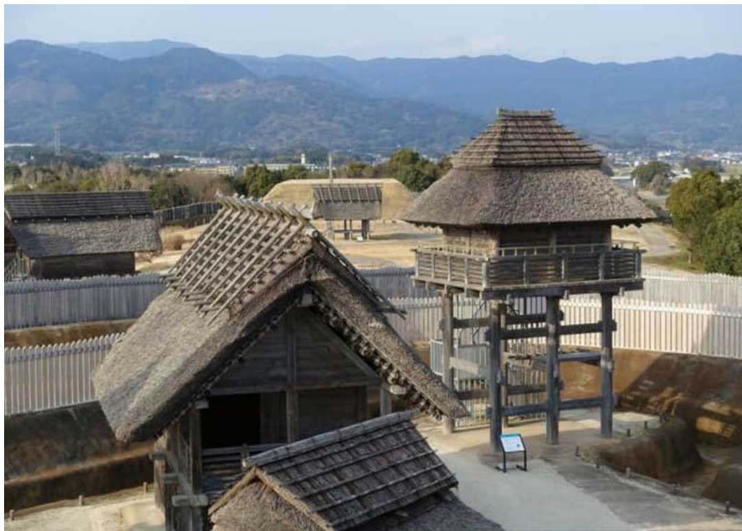
Рис. 6. Реконструированные здания и наблюдательная вышка в Ёсиногари [114].
