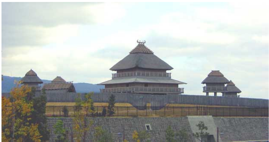
Рис. 5. Общий вид реконструированных дворцовых сооружений в Ёсиногари [113].
